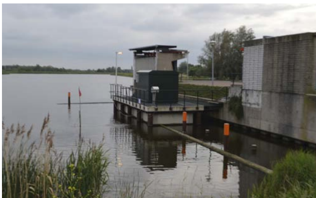
Vispassage bij Boezemgemaal Halfweg, in het Westelijk Havengebied bij Amsterdam. Doorgang van zout (brak) naar zoet water (foto: PICTAN).
